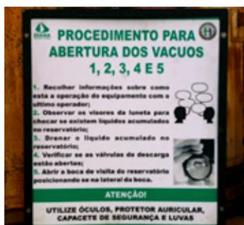
Na fábrica de açúcar foram instalados procedimentos de segurança para abertura dos vácuos, aquecedores, evaporadores e reboiler em situações de manutenções e inspeções nos equipamentos. O objetivo é evitar acidentes envolvendo líquidos em temperatura elevada que possam estar acumulados dentro dos reservatórios.
