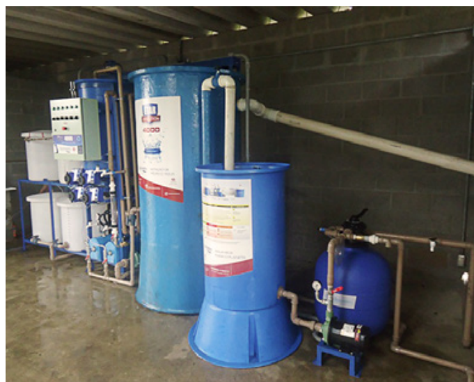
ETAR: tratamento compacto de águas residuais, com capacidade para tratar 4 m 3 /h.
