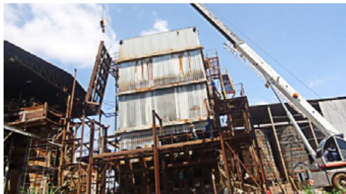
Para que o andamento das obras de ampliação não interfira no andamento da manutenção de entressafra e, posteriormente, da Safra 2014, para o planejamento de montagem durante este período estão previstos pontos de interligações das redes de vapor, água, caldo e outros, para que fiquem à espera das conclusões das redes e, assim, não seja necessário interromper a moagem por um grande período de tempo para fazer a interligação das mesmas.
