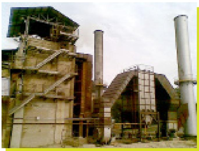
A caldeira nº4 tem capacidade de produzir 40 toneladas de vapor por hora, com uma pressão de 21kg/cm<sup>2</sup>, a uma temperatura de 300° C. Comparada às outras já instaladas, ela é a mais completa em termos de tecnologia. É composta por um lavador de gases altamente eficiente, que não emite material
