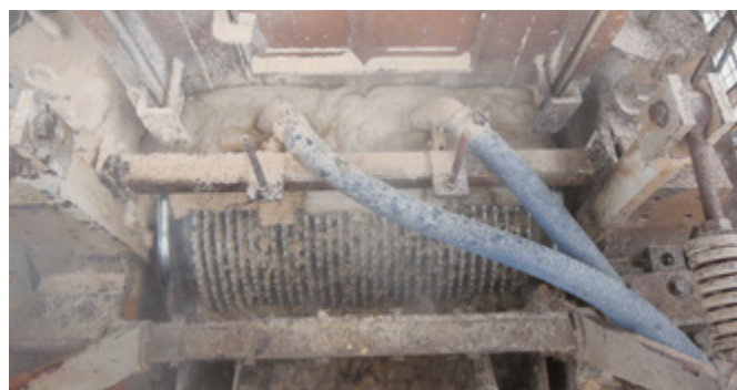
> Succionador de caldo instalado na moenda 2
