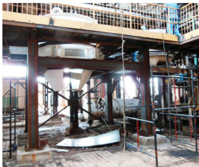
> Estrutura das centrífugas contínuas
