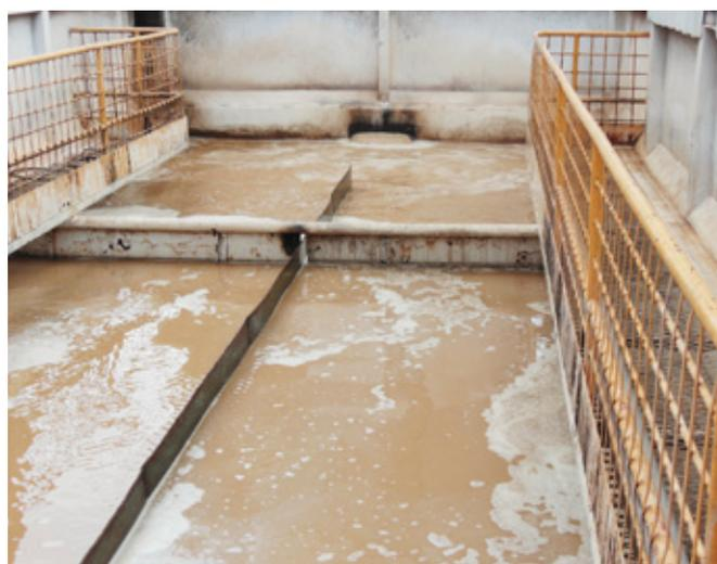
> Sedimentador de fermento (flotador)
