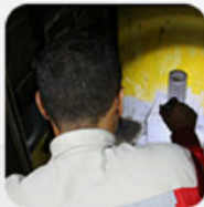
Casas de máquinas de elevador
