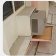
Bandejas de ar condicionado
