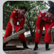
Caixas de passagem de água
